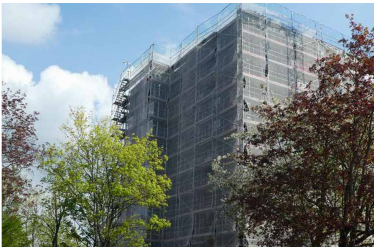
Investition fast im 2-stelligen Millionenbereich: Unsere Generalsanierung Alter Wartweg 31
